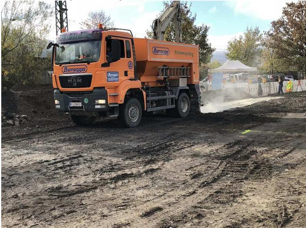
Mix in Place Verfahren durch Fräsen und Einspritzung des Nanopolymer / Wasser Gemisches vom vorausfahrenden Tankwagen direkt in den Fräsraum:
