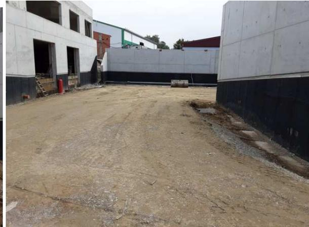
Am linken Bild sind vor Ausführung der Stabilisierungsarbeiten noch tiefe Spuren der Geräte (Bagger und LKW) zu sehen. Unmittelbar nach Fertigstellung der Stabilisierungsarbeiten sind keinerlei Verdrückungen mehr zu sehen.
