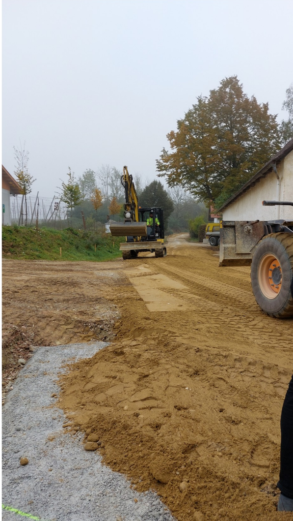
Vorlegen von sandigen Kiesmaterials
