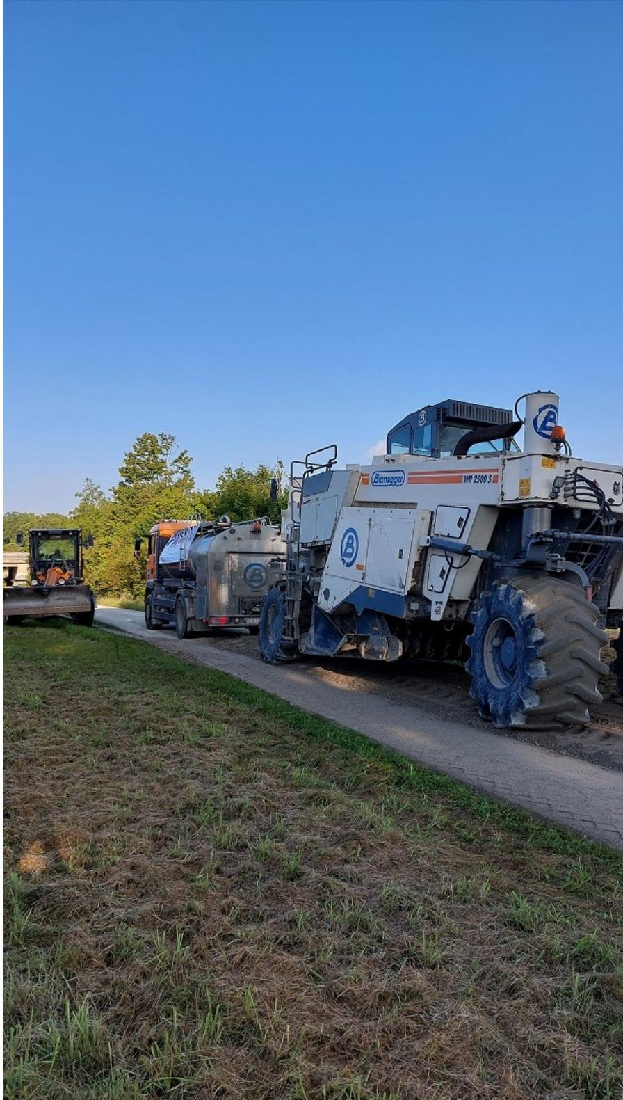
Fräsgang mit Eindüsung des Wasser- Polymergemisches
