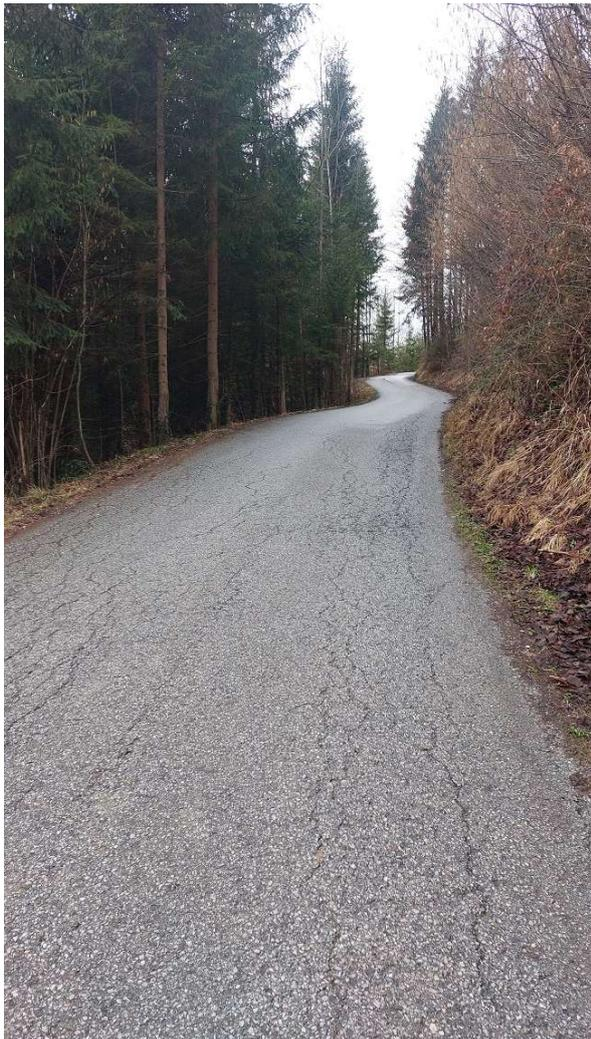
Situation vor der Sanierung – Deutlich zu erkennen – Rissbildung aufgrund des Unterbaus
