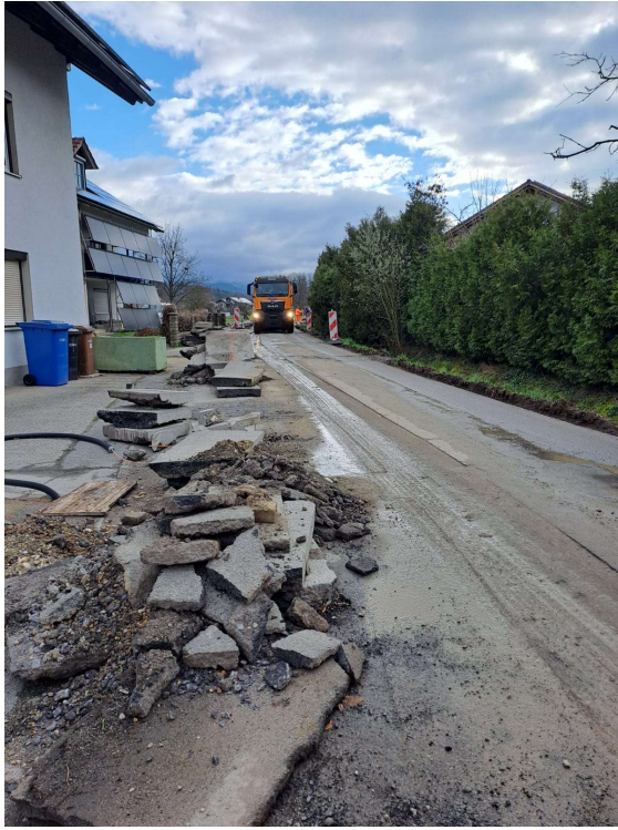
Das Aushubmaterial der Vorarbeiten Wurde recycelt
