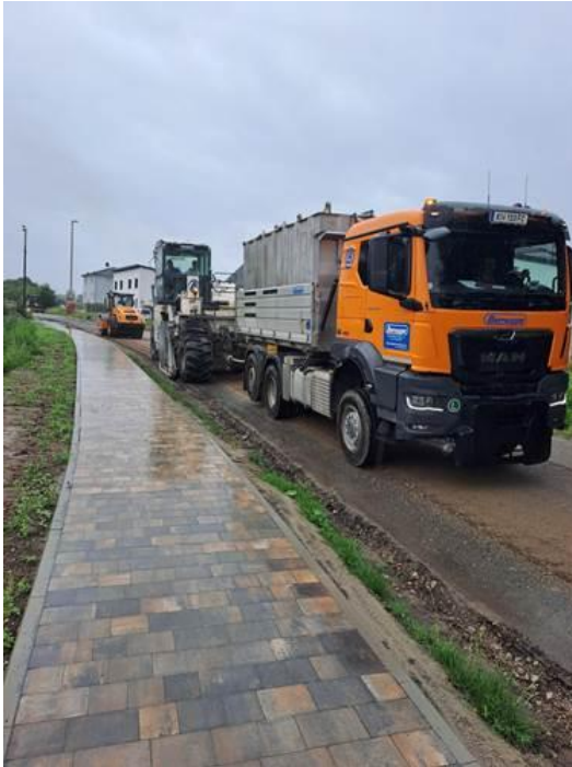
Erster Teilabschnitt wird stabilisiert
