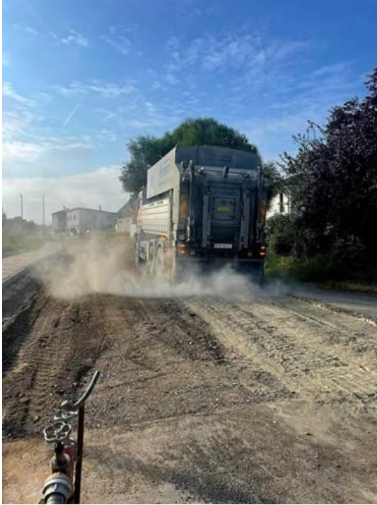
Zement wird vorgelegt
