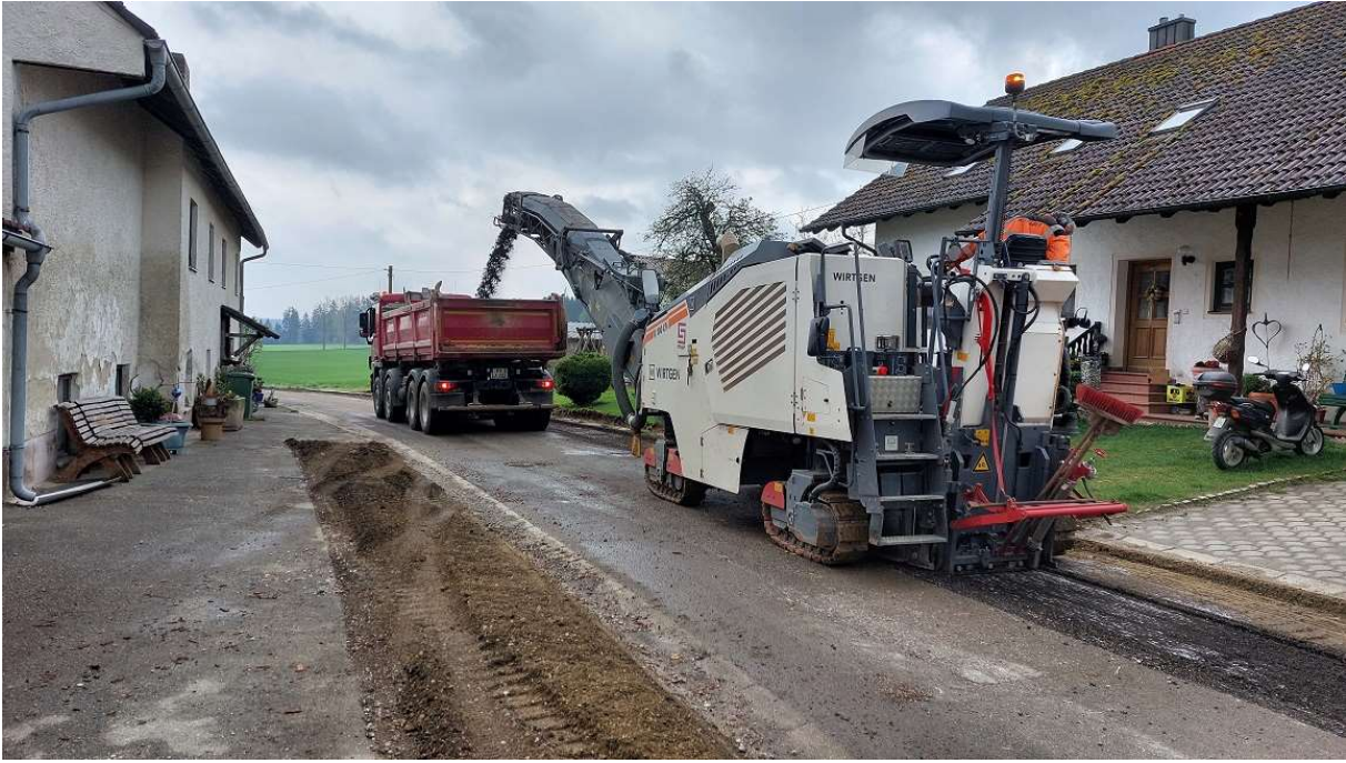
Asphaltfräsarbeiten im Bereich der Rinnsteine
