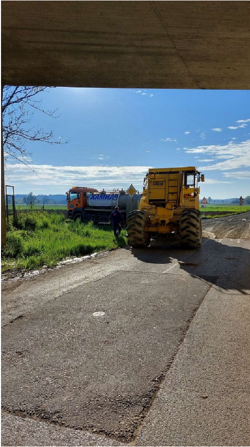
Stabilisierung mit Fräse und Wasserwagen
