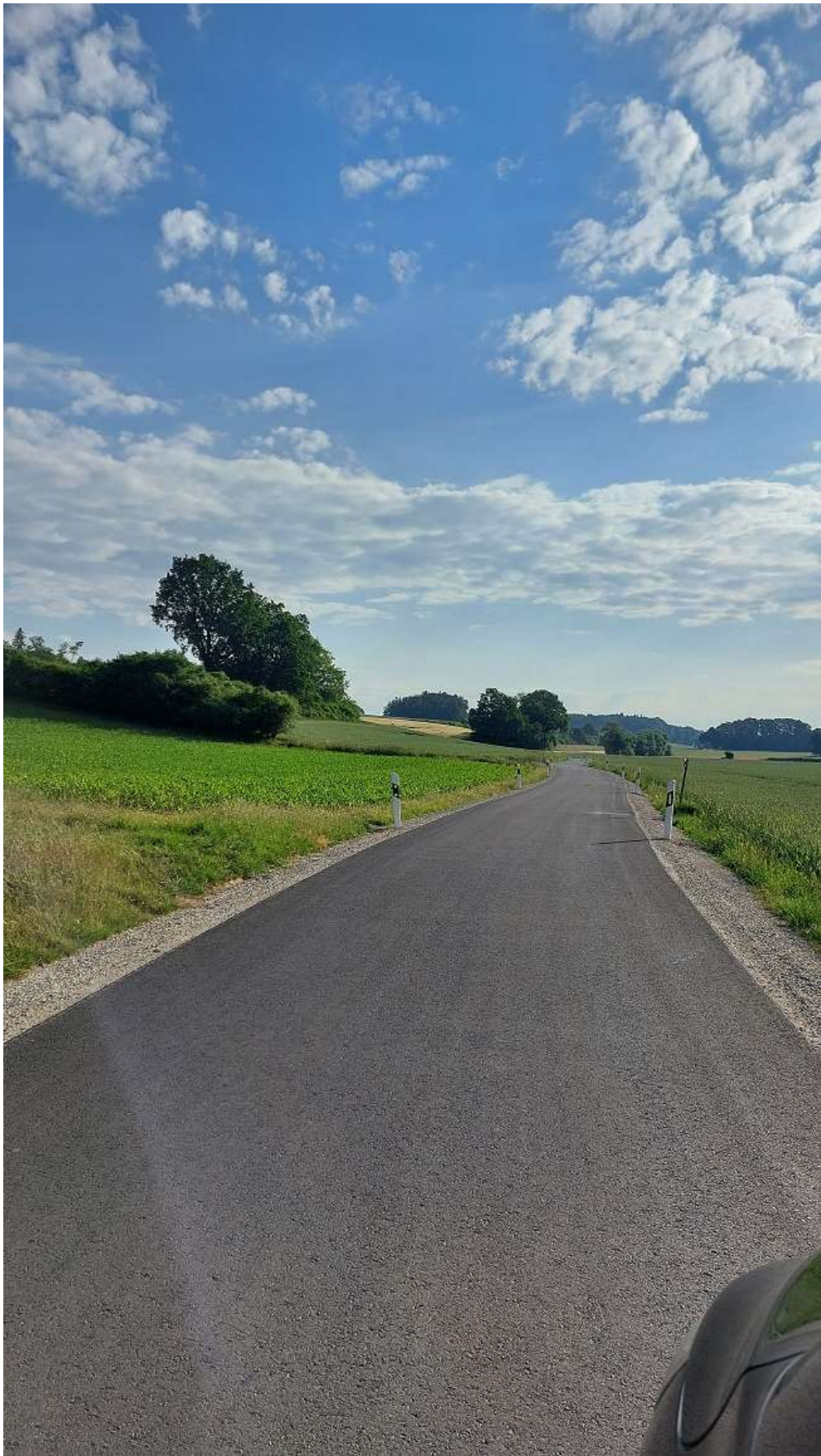
Nach Ausführung aller Arbeiten
