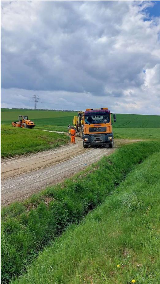
Stabilisierung mit Fräse und Wasserwagen
