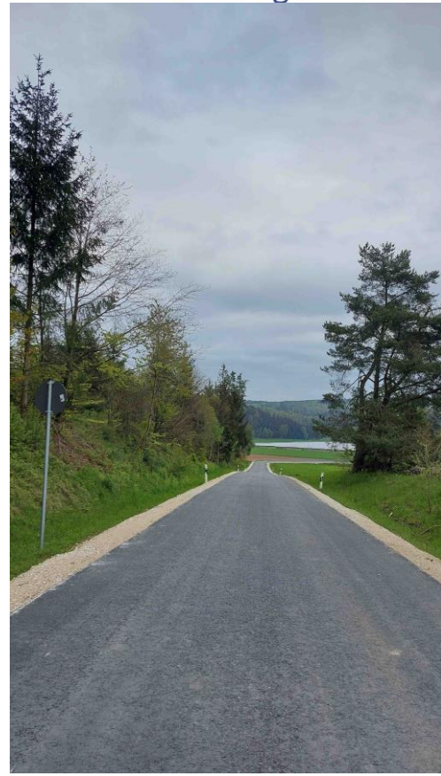
Nach Fertigstellung der Bankette
