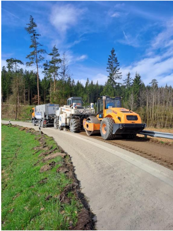
Fräsarbeiten bei schönstem Wetter
