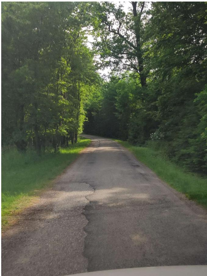
Situation vor der Sanierung – die vorhandene Asphaltenschicht bröckelt ab und Schlaglöcher entstehen
